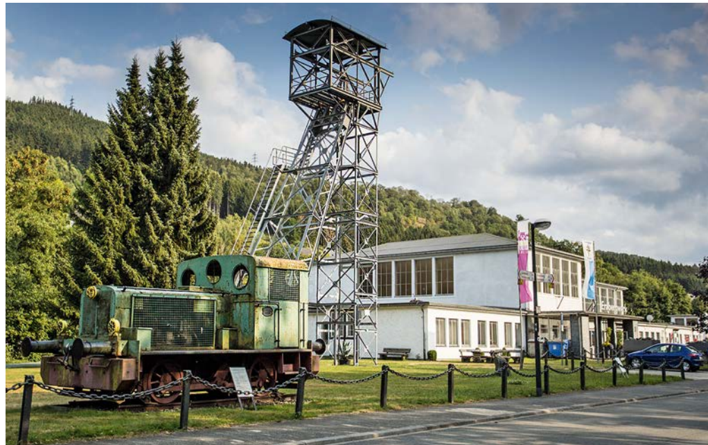
Das Kauengebäude von 1953 und das charakteristische Fördergerüst
