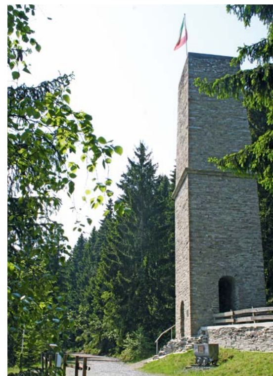
Der Rauchgaskamin ist eine Station des Bergbauwanderwegs.
