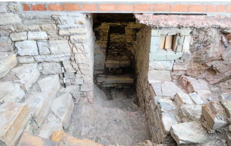
Blick vom Vor- und Arbeitsraum auf den Feuerungskanal im Inneren des Ofens. Rechts oben die sorgfältig aus Werksteinen gesetzte Zarge des Rauchgasabzugs mit (heute fehlender) Klappe. Foto: LWL/Wolfram Essling-Wintzer
